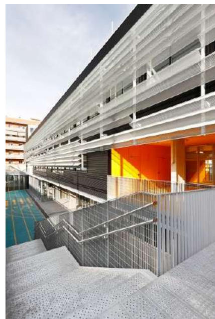
Imatge de les proteccions solars
