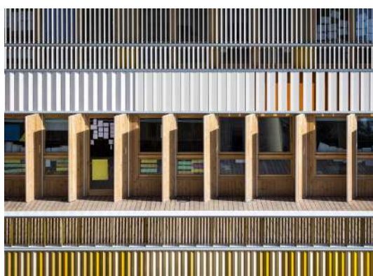
Imatge de les proteccions solars
