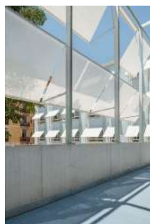
Imatges de les proteccions solars
